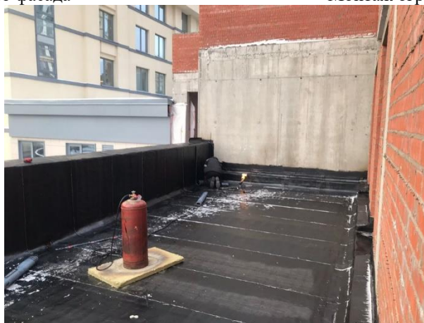
Устройство кровли террас
