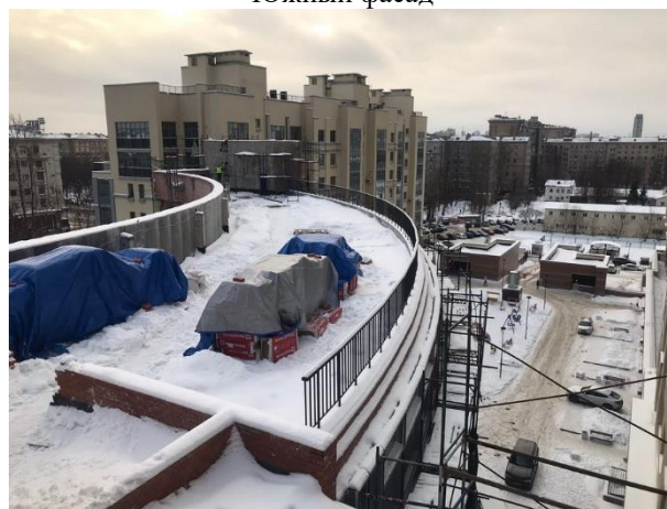
Монтаж ограждения кровли
