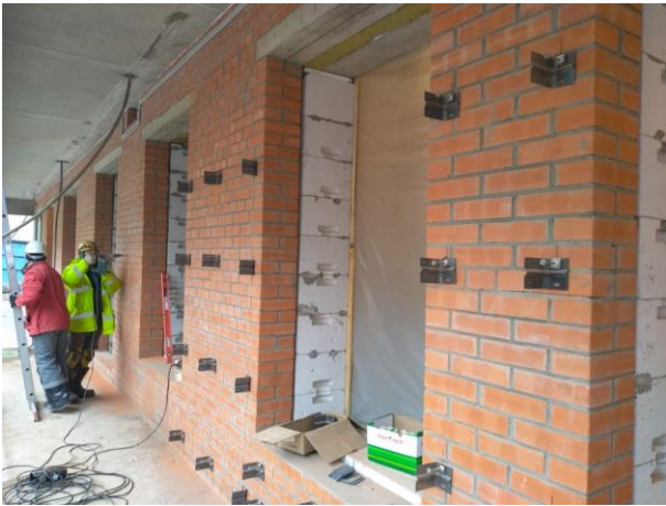
Монтаж кронштейнов для гранитной облицовки
