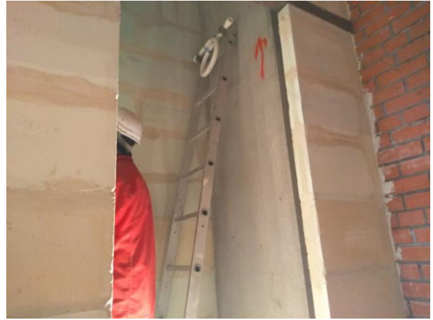
Монтаж системы ХВС, ГВС в кв.
