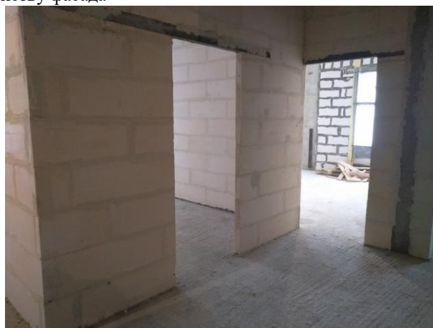
Межкомнатные перегородки
