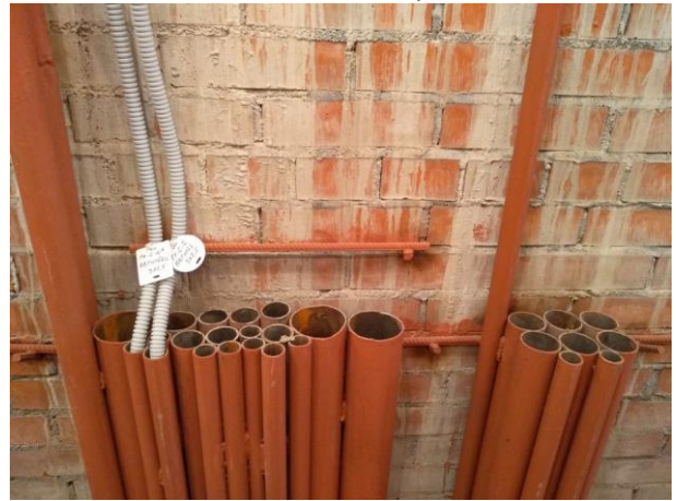
Монтаж слаботочных систем в МОП
