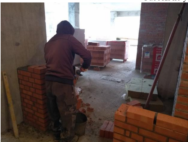
Возведение межквартирных стен
