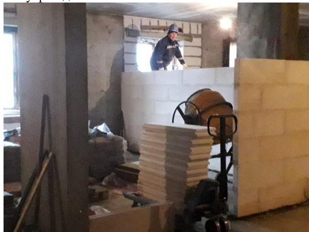
Установка межкомнатных перегородок
