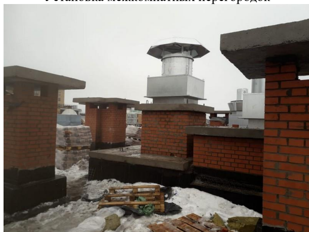
Монтаж системы вентиляции на кровле
