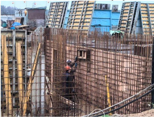
Бетонирование стен подвала
