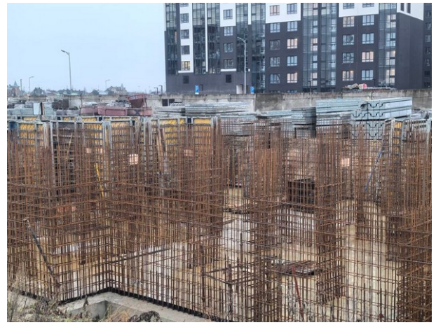
Армирование стен подвального этажа
