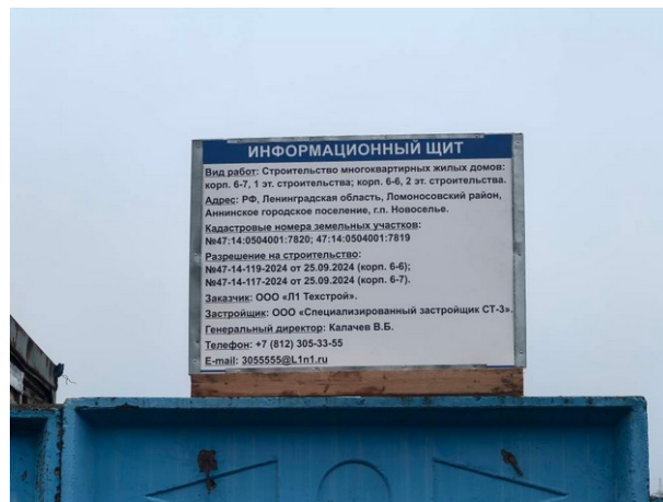
Информационный щит объекта
