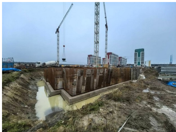
Строительная площадка корпуса
