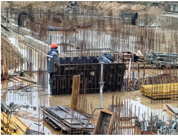
Армирование стен подвального этажа
