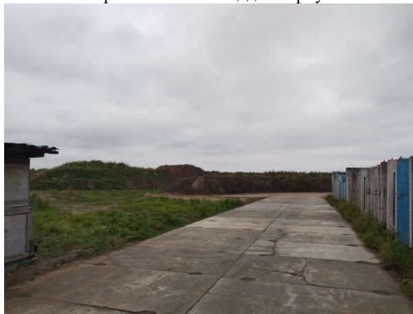
Устройство временной дороги
