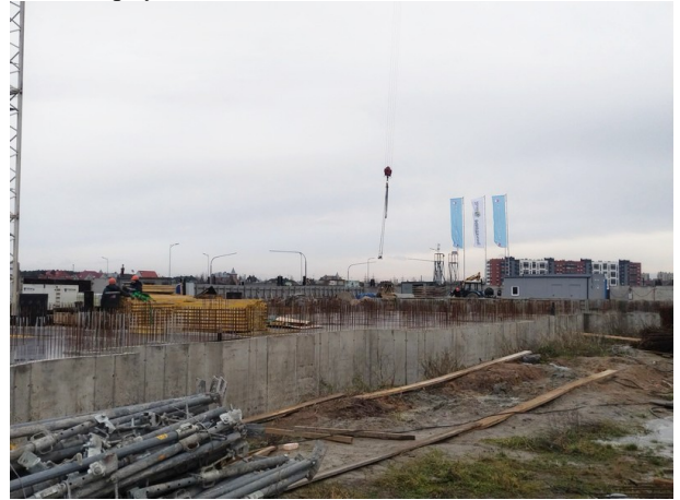
Работы по устройству перекрытия подвала
