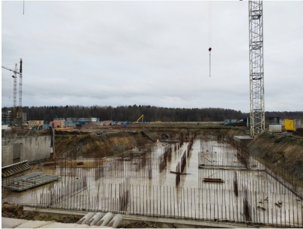
Работы по устройству стен подвала
