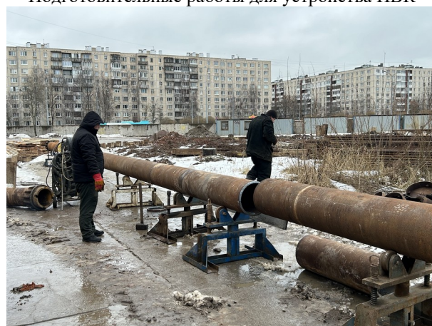
Подготовка труб для бурения отверстий
