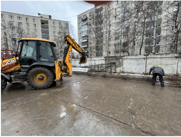
Подготовка армированного каркаса для бетонирования конструкций забивания свай
