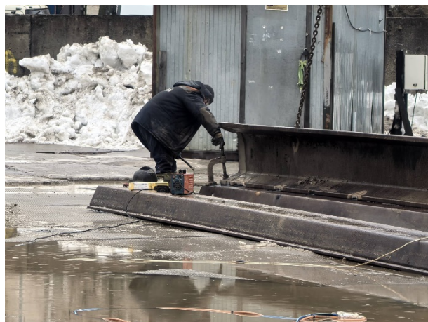
Подготовка (сварка) шпунтового ограждение котлована перед установкой
