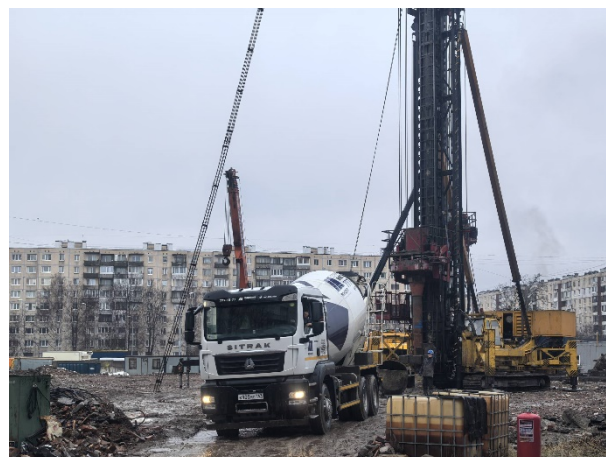
Подготовка и монтаж свайных конструкций
