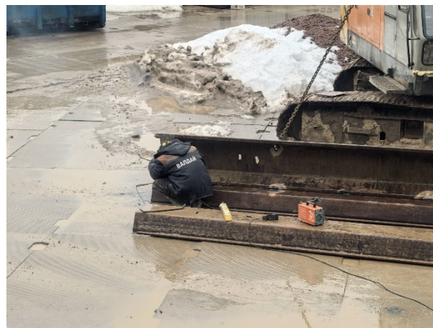
Подготовка (сварка) шпунтового ограждение котлована перед установкой
