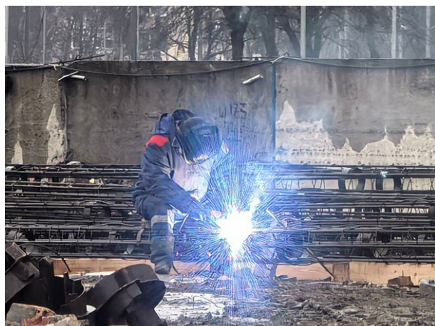
Подготовка и монтаж свайных конструкций
