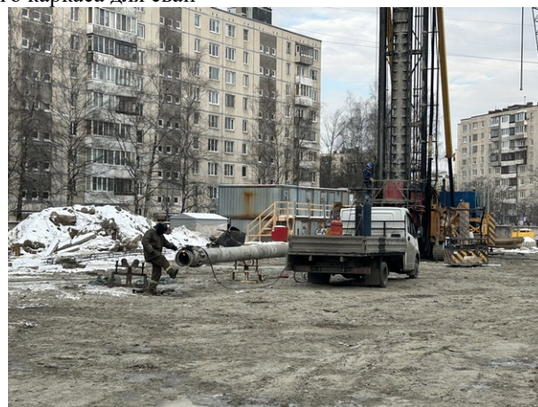
Подготовка обсадной трубы.
