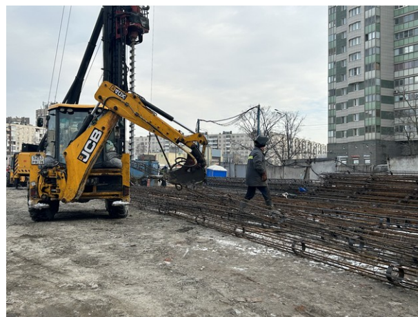
Подготовка арматурного каркаса для свай
