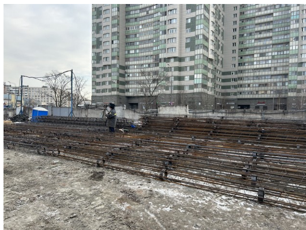
Подготовка арматурного каркаса для свай
