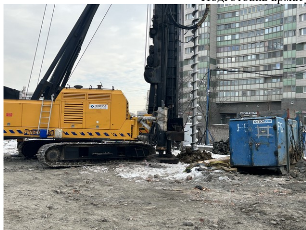
Буровая установка выполняет лидерное бурение
