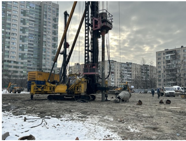
Установка обсадной трубы для укрепления скважины
